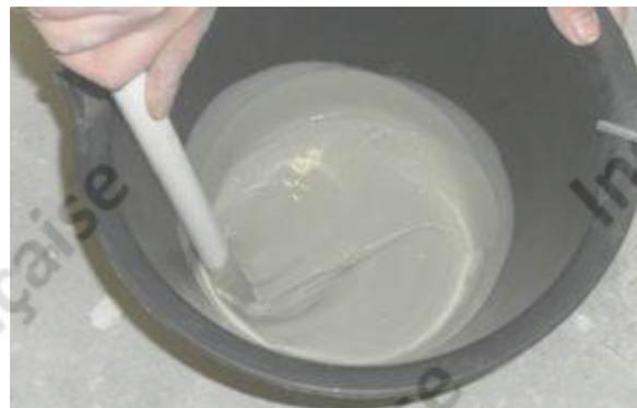
Mélanger les deux composants à 50/50. Le mouvement imprimé doit avoir la forme d'un 8.
