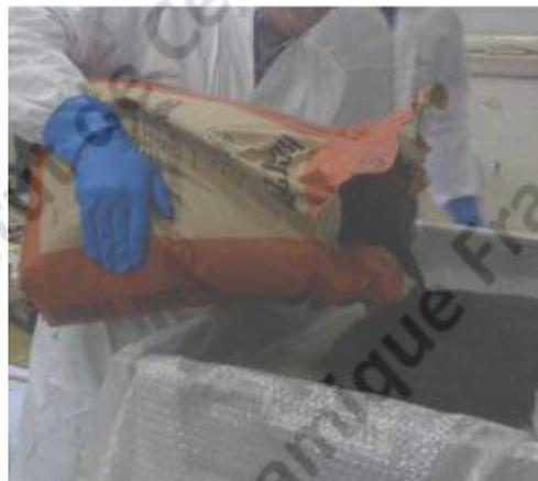
Dosage de la résine selon les mêmes proportions que pour la couche de liaison. Préparation de la résine de stratification, résine plus durcisseur sans talc. Mélanger avec un agitateur.
