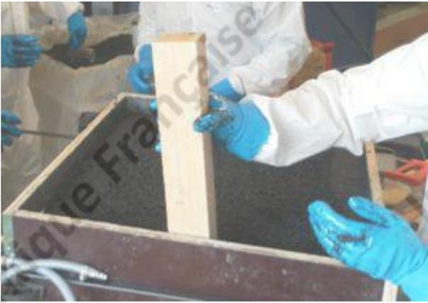
Damage du béton.
