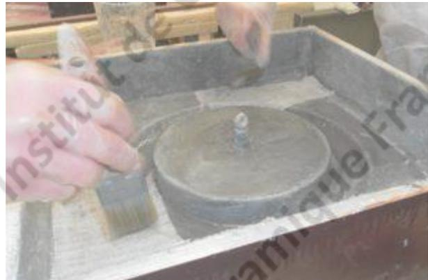
Il ne doit subsister aucune bulle d'air entre les différentes couches de résine et de fibre de verre.
