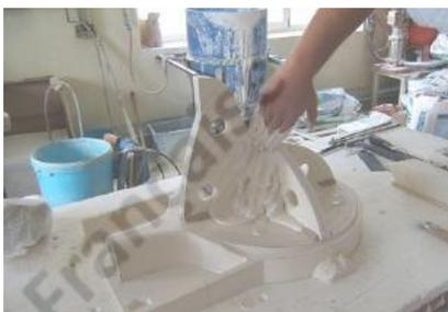
Remplissage de plâtre entre les plaques
